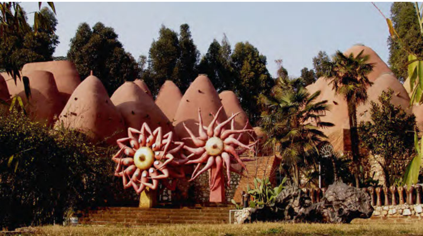
Earth Nest, konstruiert 1996
